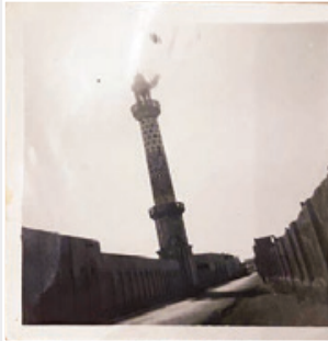
مكتبة يوسف كافي، كان صلاح، هذا المبنى، تشاركه مكتبة كلاً من: قريش، من البحر (١٠) وهو مركزاً حيوياً للثقافة والتعليم... من أبرز الأبنية في المنطقة (بإشراف فاضل منسي)
